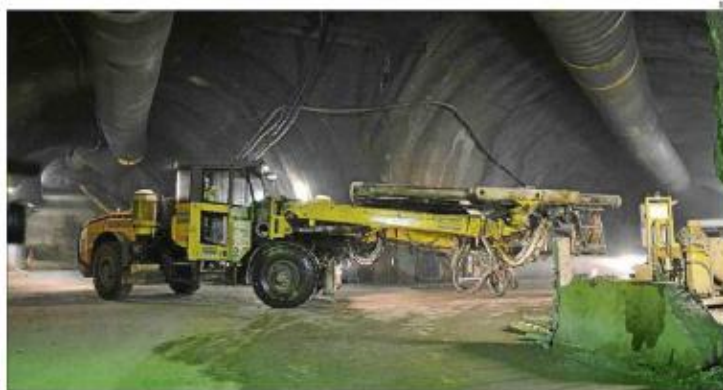
Màquina treballant a l'interior de la mina de Sùria
